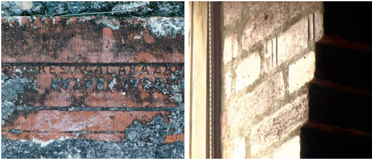
Izquierda: Escuela de Ballet, foto del fondo de una mesa con el nombre de los tejares de origen impreso. Derecha: Escuela de Teatro, detalle de un muro con el sistema de identificación impreso en los ladrillos resaltado. Foto de Christian Zecchin.
