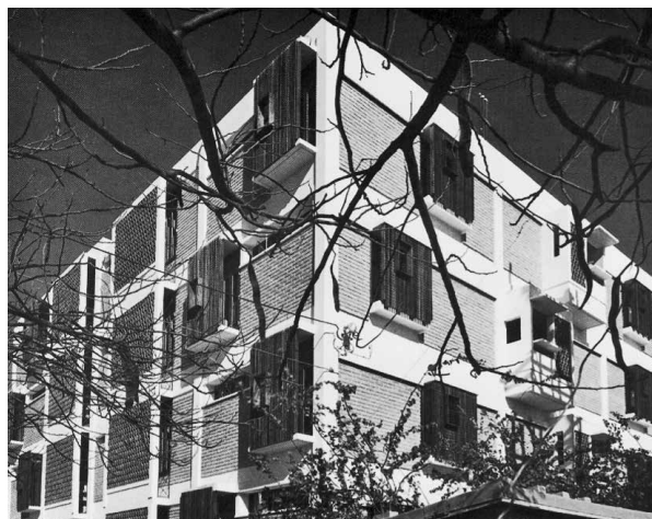
Mario Romañach, Edificio de viviendas de la Compañía Territorial de la Sierra, S.A., 1956. Fuente La Habana arquitectura del siglo XX , editado por Eduardo Luis Rodríguez, ediciones Blume, 1998, ISBN 84-89396-17-5.
