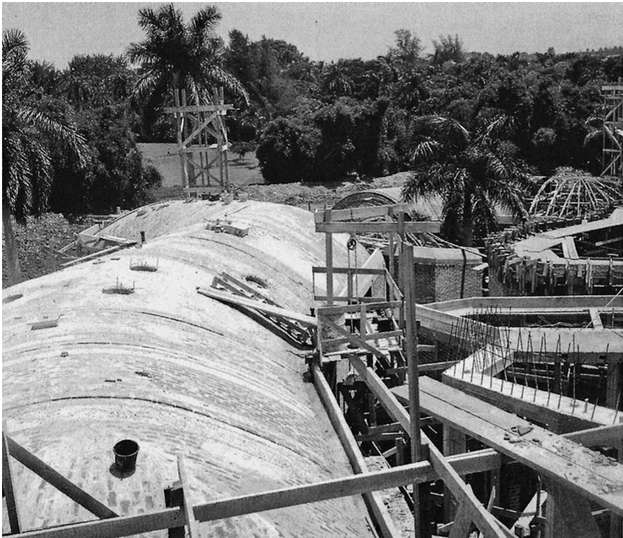
Vista de las cúpulas de la Escuela de Teatro en construcción. Cortesía de Roberto Gottardi.
