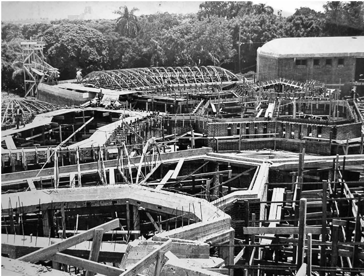
Foto de la Escuela de Teatro en construcción. Se destacan los bordillos de hormigón armado que actúan como punto de apoyo de las cubiertas abovedadas. Al fondo las nervaduras dispuestas para la colocación de las diferentes capas de azulejos. Cortesía de Roberto Gottardi.
